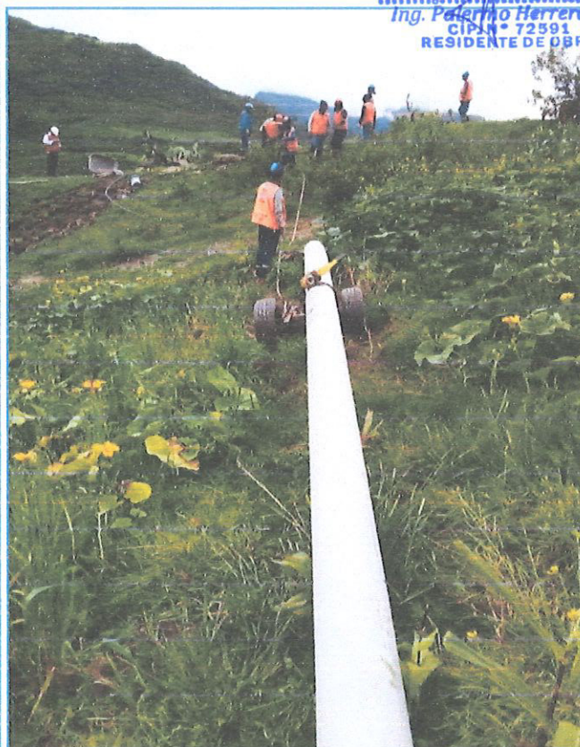
FOTOGRAFIA 07: Traslado de poste al punto de Izaje
